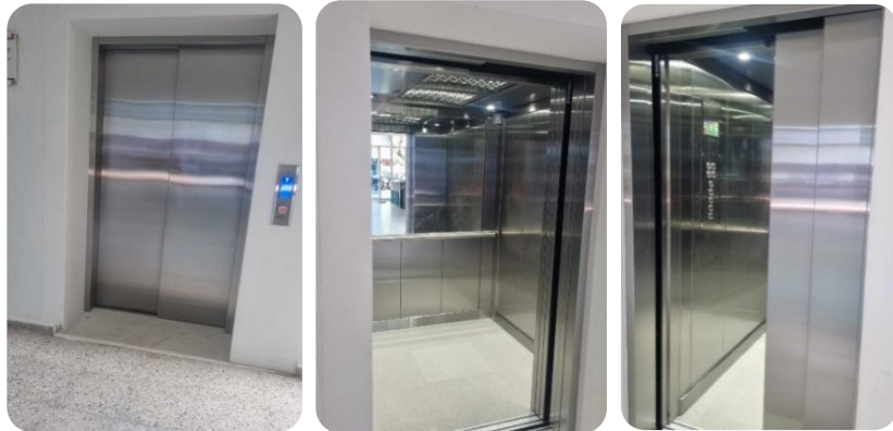
Ascensor Edificio de Artes
