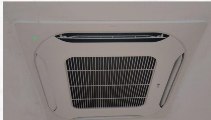
Dotación e instalación de aire acondicionado: $11.800.000
