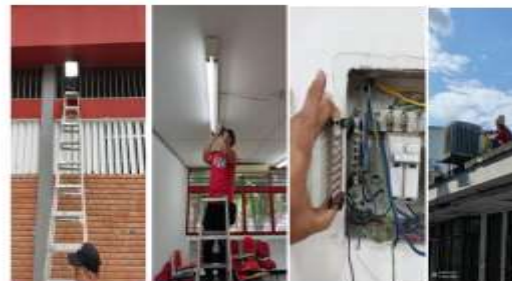
Gimnasio de Fuerza Aulas de clase Educación Aula 217 Mantenimiento aula 168-170-172
