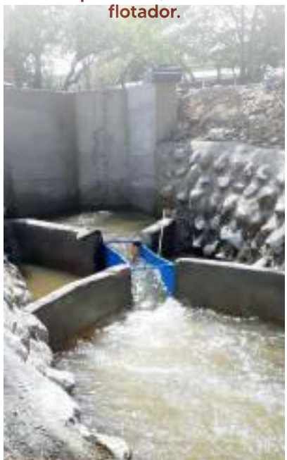
Dispositivo tipo canaleta para medir caudales prediales, a través de un flotador.
