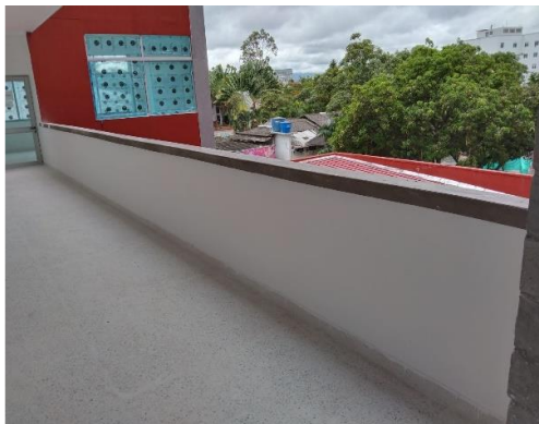
Foto 5. Terminado de instalación del antepecho, aplicación de estuco y pintura tipo 1 en el piso 2 del bloque 1.
