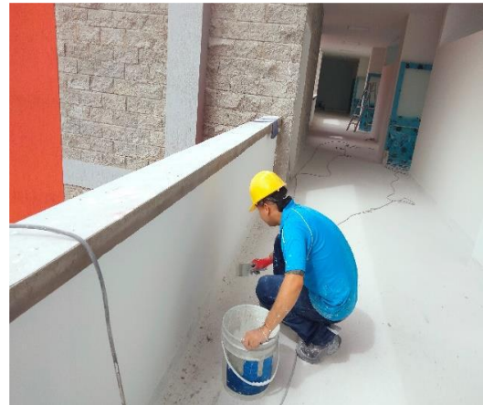
Foto 4. Aplicación de pintura tipo 1 en antepecho del piso 3 del bloque 1.
