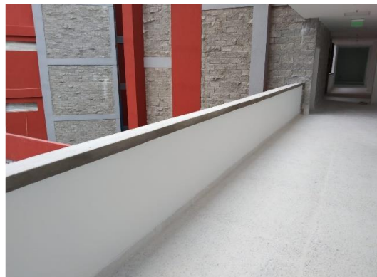
Foto 6. Terminado de instalación del antepecho, aplicación de estuco y pintura tipo 1 en el piso 3 del bloque 1.
