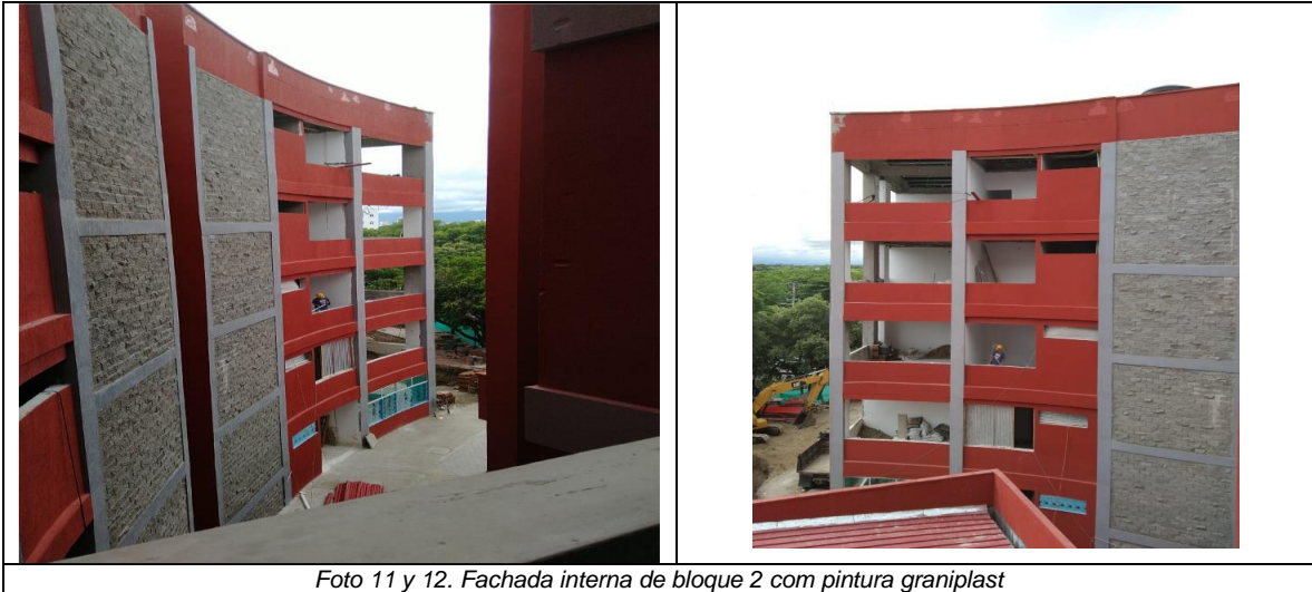
Foto 11 y 12. Fachada interna de bloque 2 con pintura graniplast
