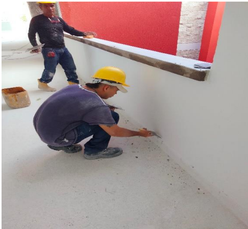
Foto 3. Resane de estuco dañado por humedad en piso 2 bloque 1.
