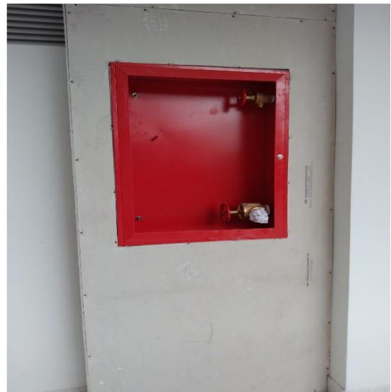
Foto 19. Gabinete tipo III red contra incendios piso 2 bloque 1. con muros en superboard
