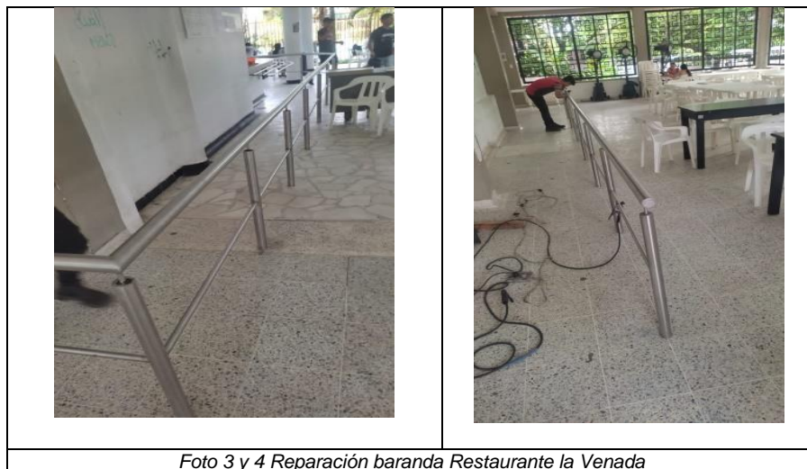
Foto 3 y 4 Reparación baranda Restaurante la Venada
