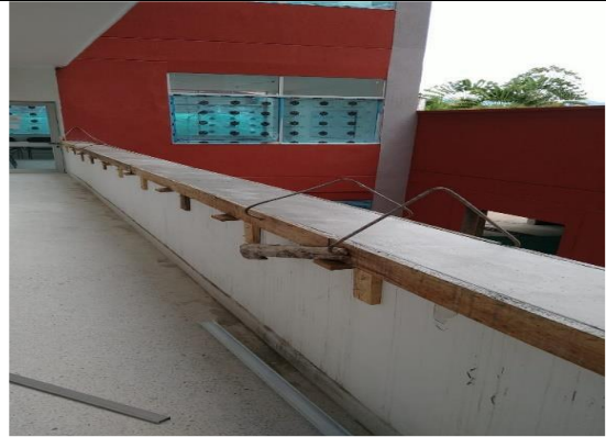
Foto 2. Fundida de alfaja en concreto de antepecho del piso 2 bloque 1.
