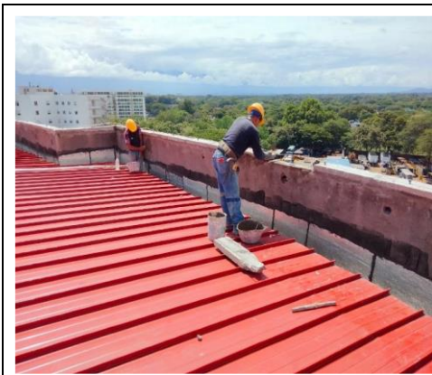
Foto 13. Reinstalación de alfajías en muro de cubierta de bloque 2.
