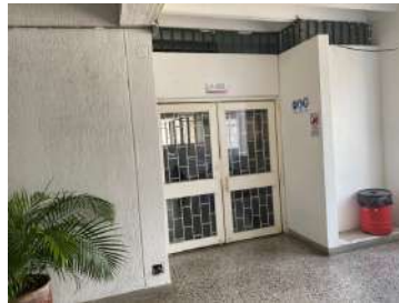
Imagen de instalaciones originales (antes de las adecuaciones)
